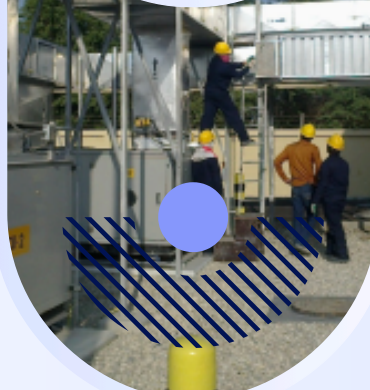
تركيب مجاري الهواء
